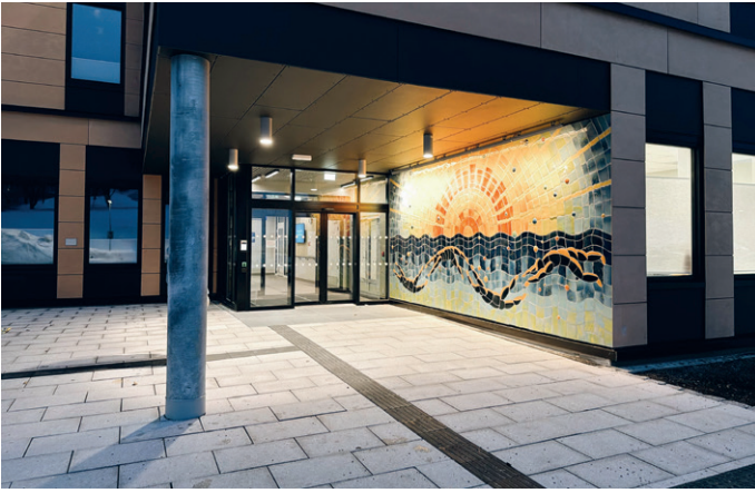
I oktober i fjor ble det nye helsehuset i Harstad kommune tatt i bruk av helsepersonell og pasienter. Foto: Øivind Arvola/Harstad kommune
